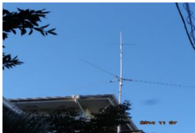
観測使用アンテナ 4el GP 給電点は屋根下より 1m 高
